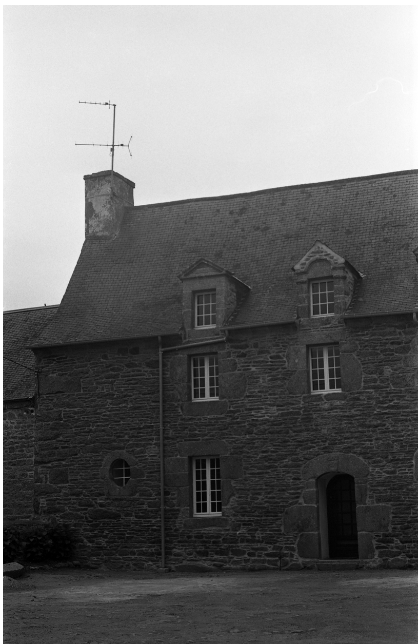
Vue générale de la façade sud
