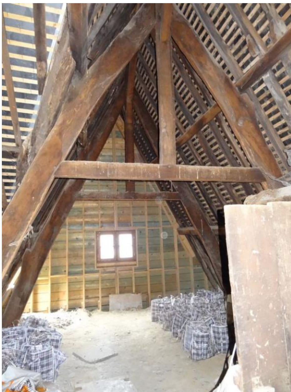
Partie sud des combles
