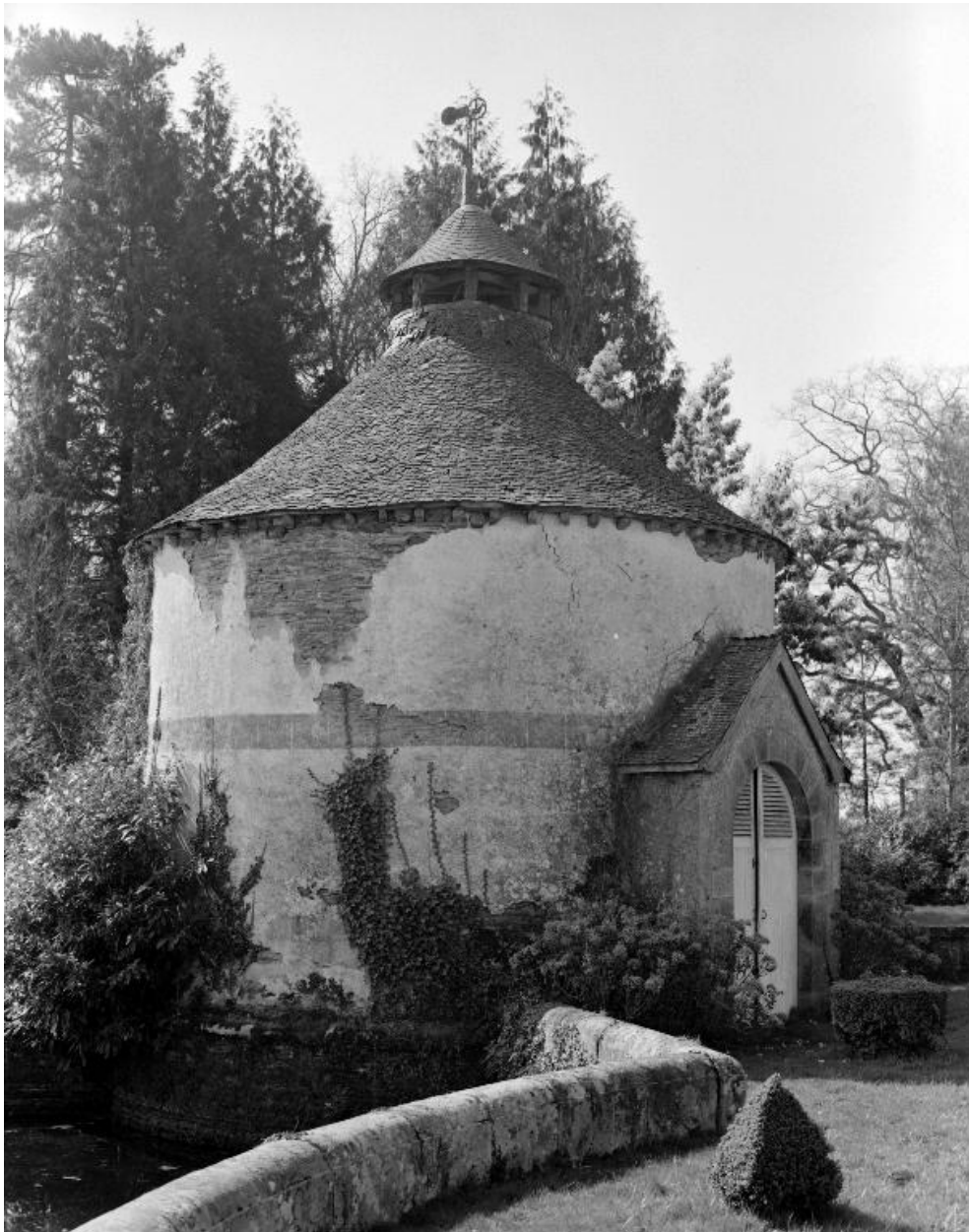
Château : le colombier (état en 1984)
