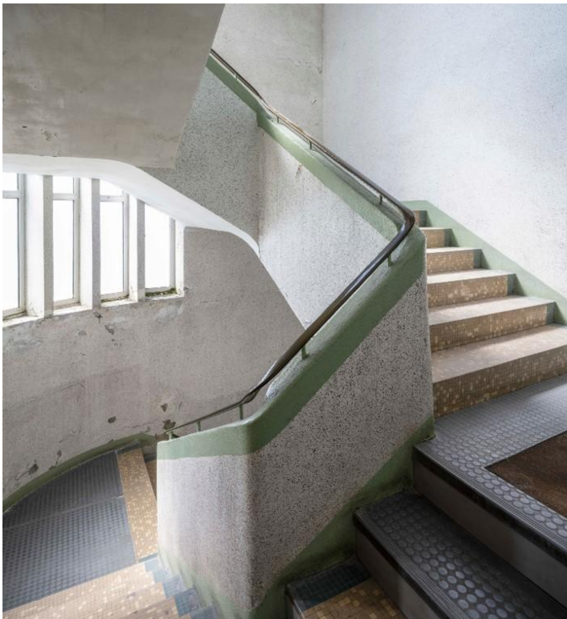
Escalier et palier de la criée de 1952
