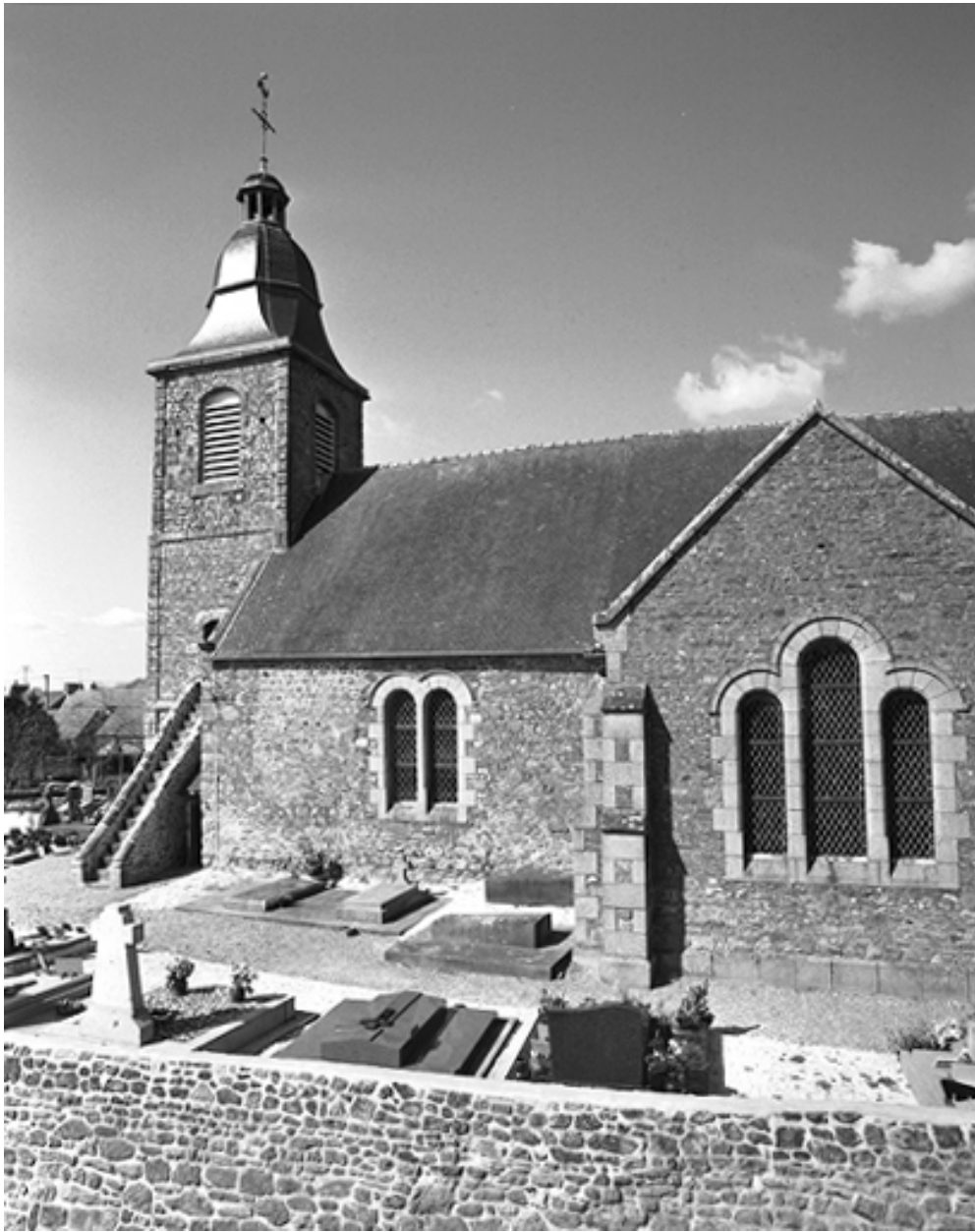
Vue partielle sud-ouest
