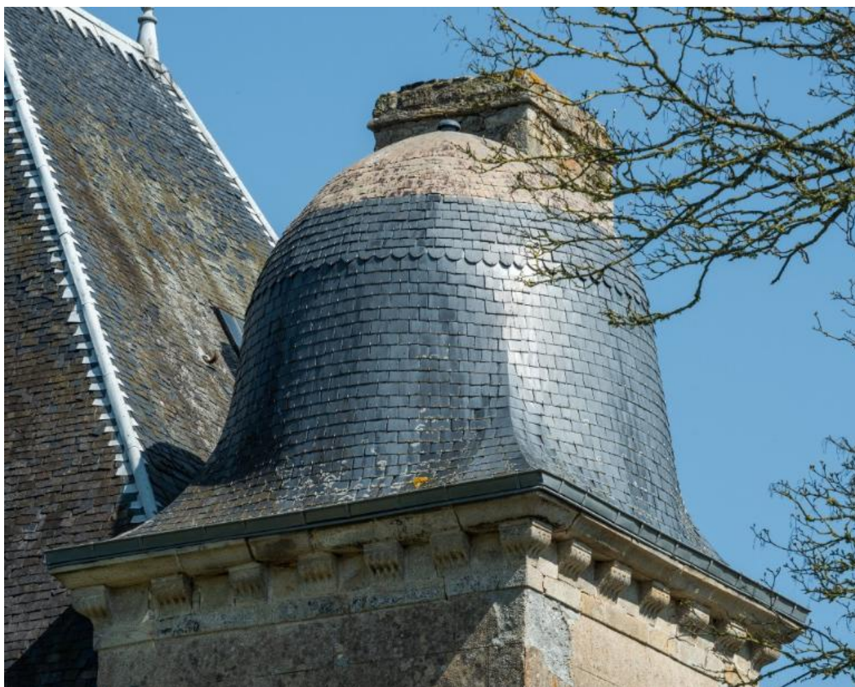
Détail de la toiture du pavillon Renaissance
