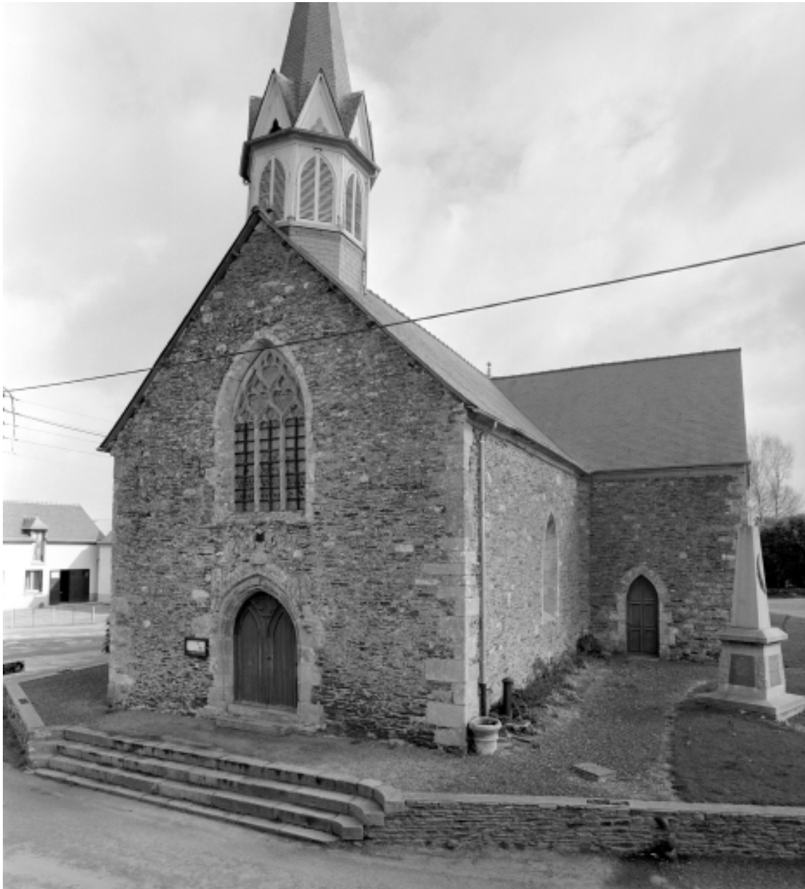
Elévation Ouest : vue générale
