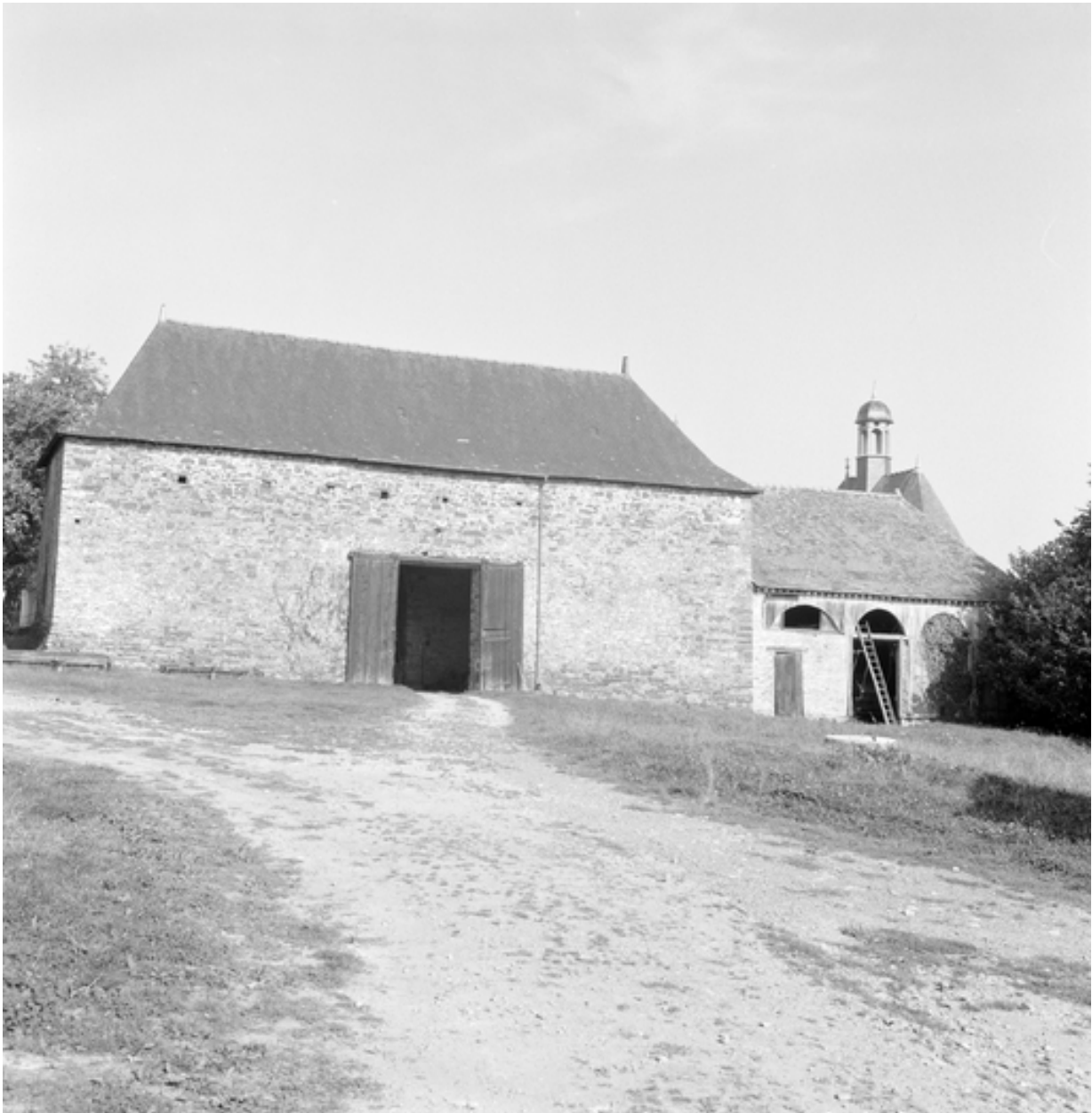
Dépendances, vue générale sud.
