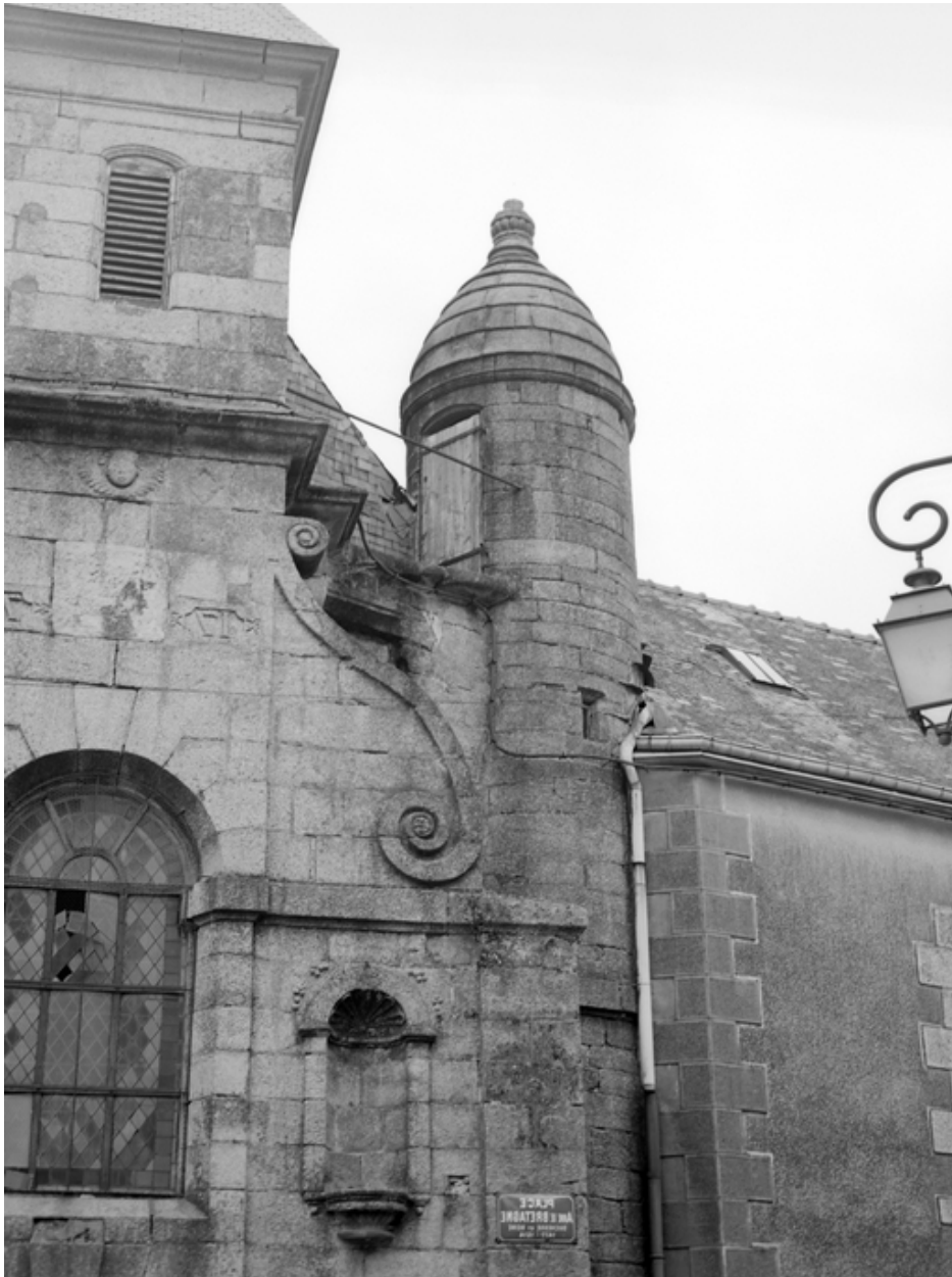
Vue du dôme de la tourelle d'escalier à l'ouest de la façade principale sud.
