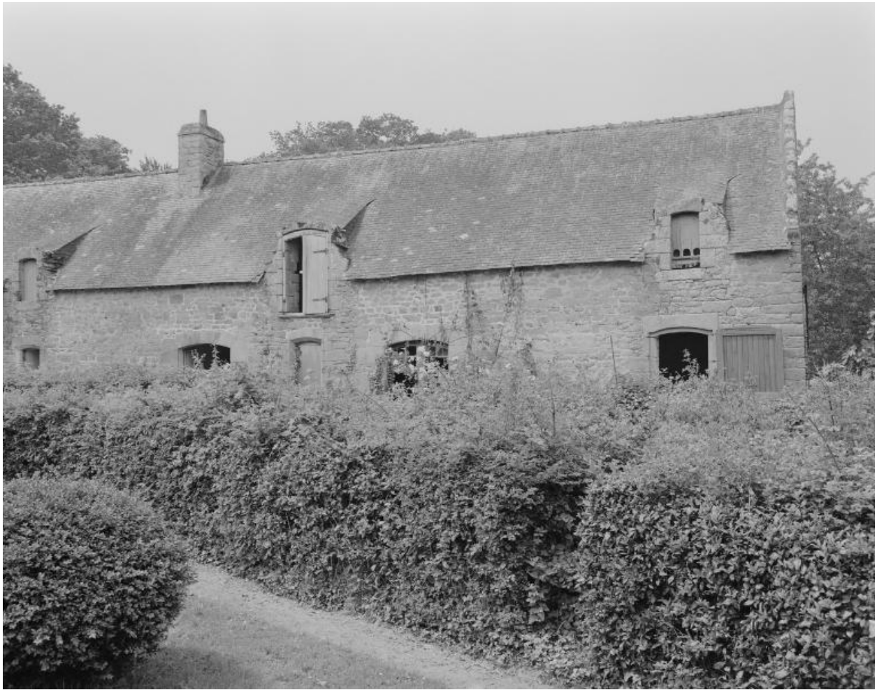
Communs, partie nord, élévation est.
