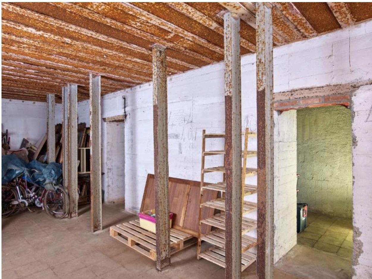
Vue intérieure : grande salle nord. Les poutrelles verticales permettaient de caler les munitions (en caisse en bois pour deux projectiles, sur 6 ou 7 caisses de hauteur ou en container métallique simple) et de délimiter un couloir de distribution
