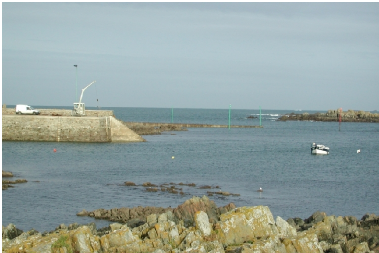
La grande cale et sa grue de levage
