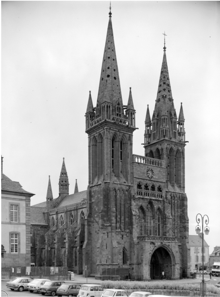
Vue générale prise du nord-ouest
