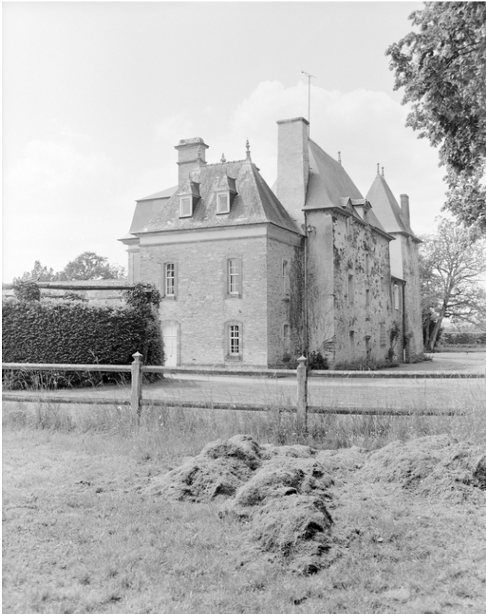
Vue générale sud-est de l'élévation postérieure.
