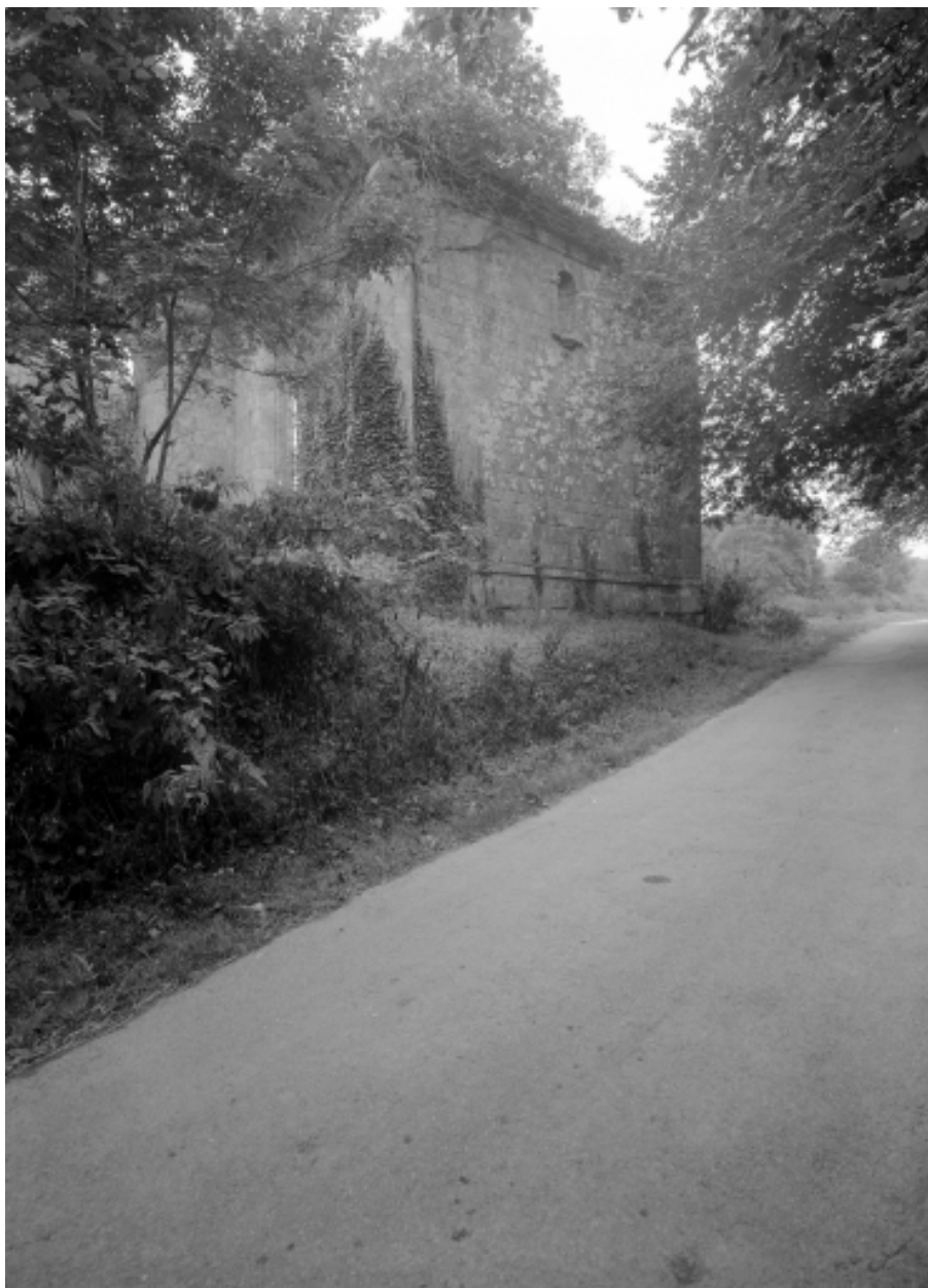
Chapelle, mur nord du bras de transept nord
