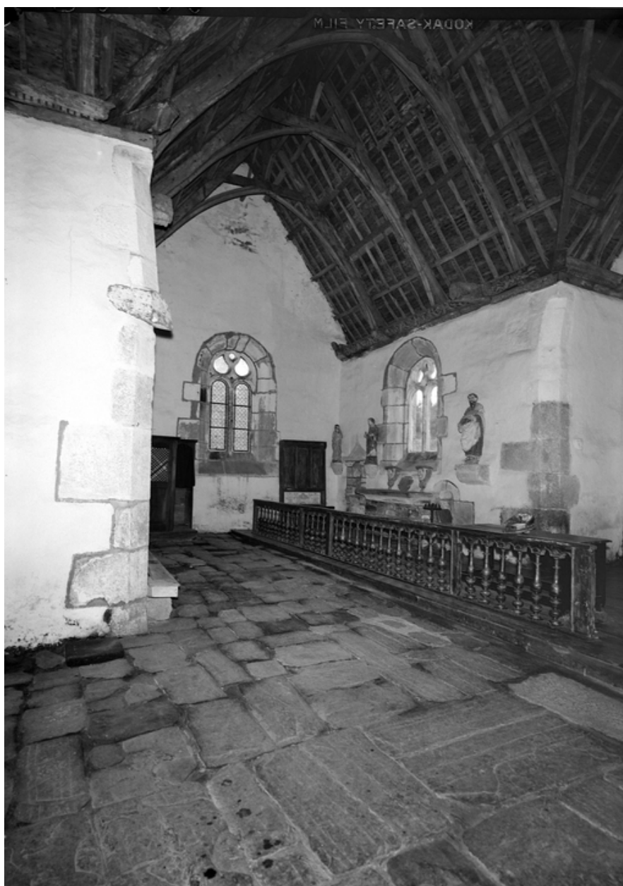
Vue du bras nord du transept
