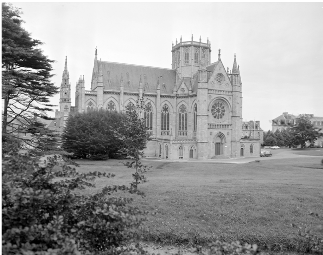
Chapelle, vue générale vers le sud (1974)
