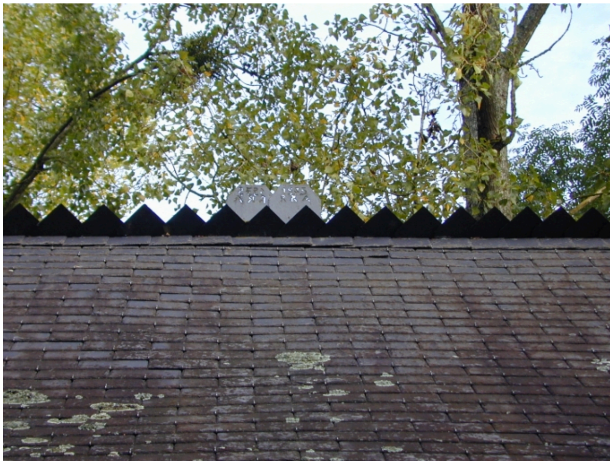
Faîtage, ardoises datées : détail
