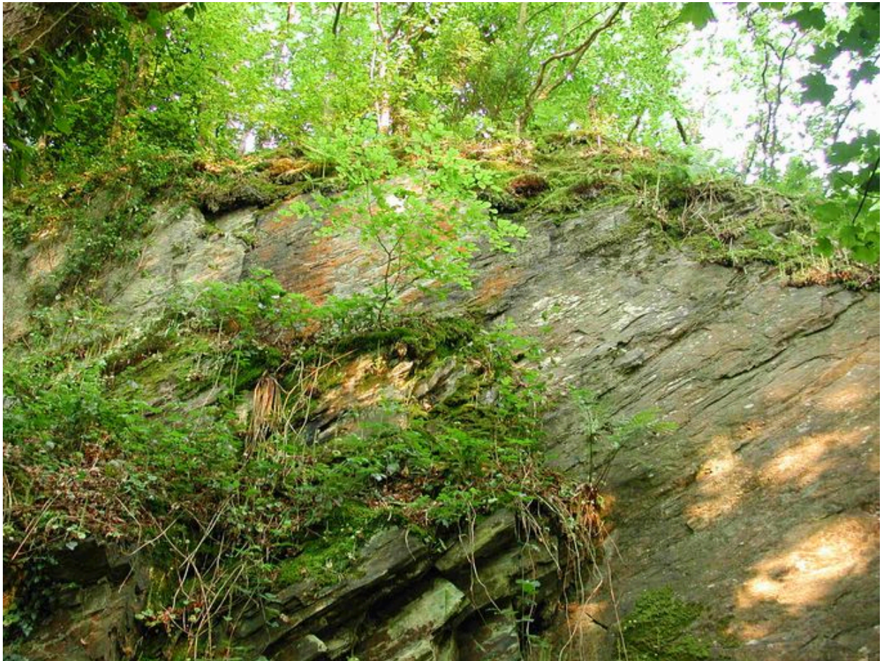
Vue d'une microfalaise schisteuse : ancien front de taille d'une ardoisière
