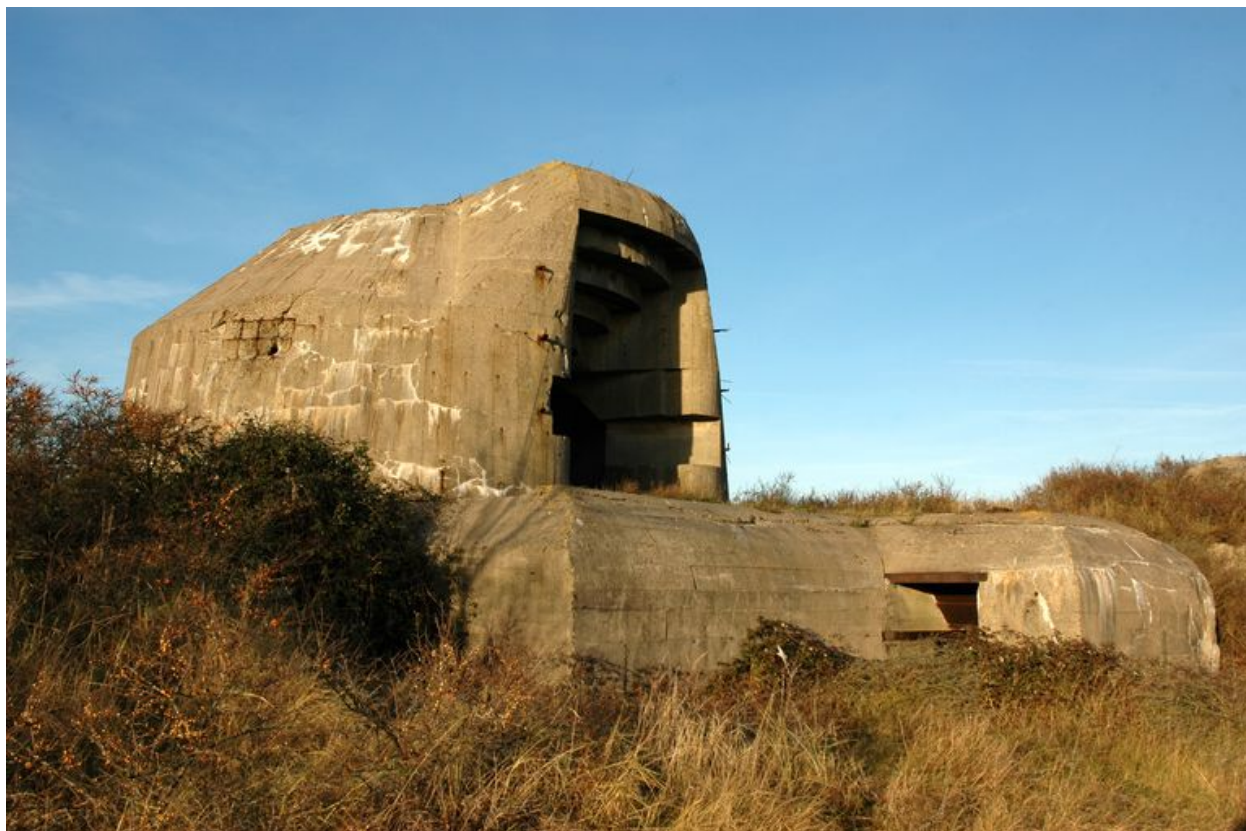
Pas-de-Calais : vue de la casemate expérimentale de la batterie Waldam dite batterie du fort Vert (casemate tournant à 360°)
