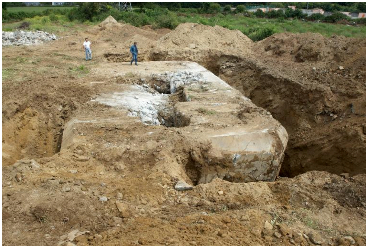
Déconstruction d'un bunker de type 502
