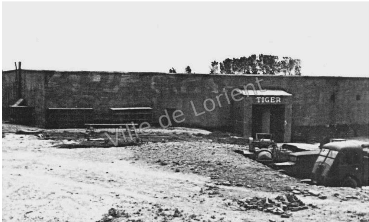
Vue du bunker baptisé Tiger
