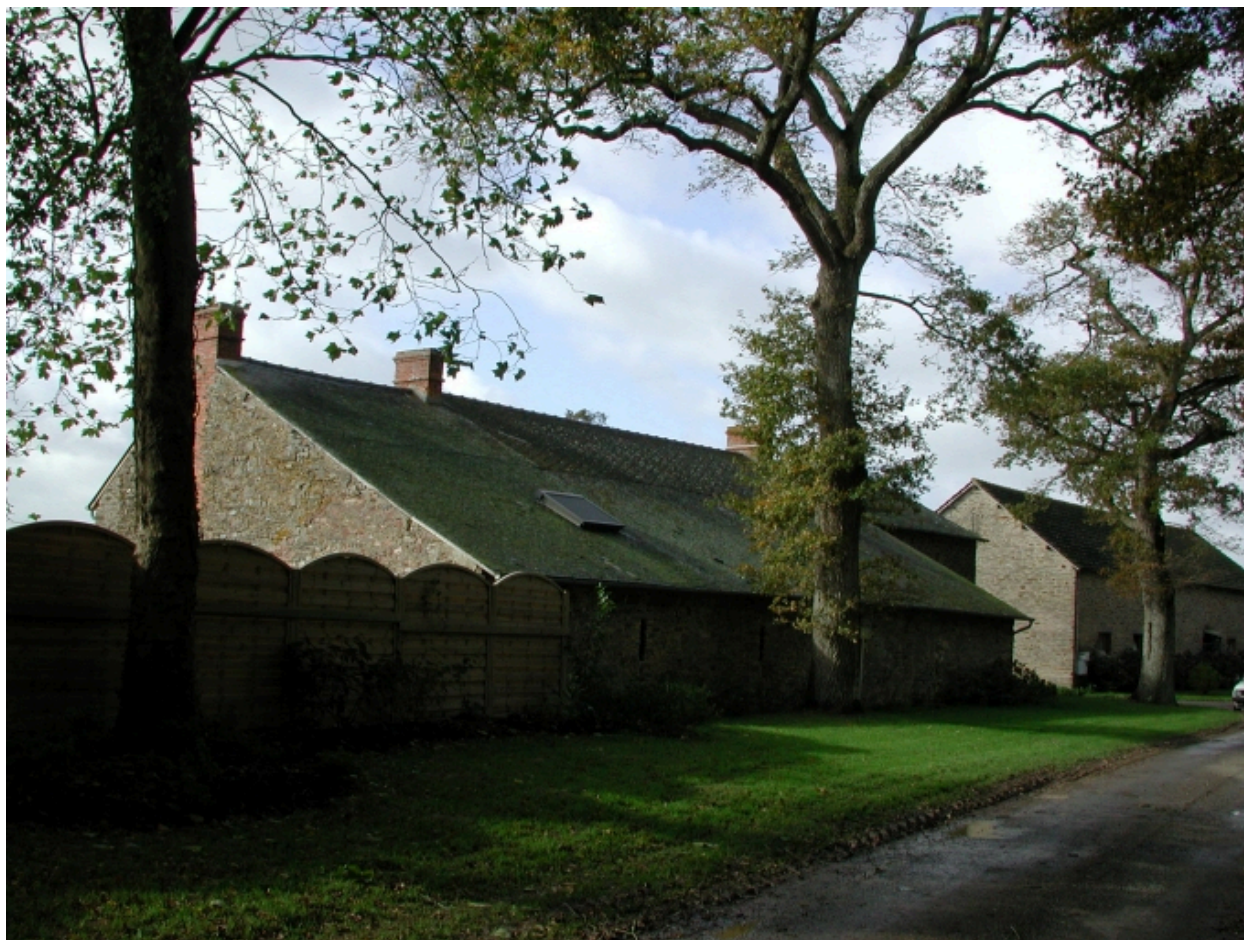
Ferme ; vue de situation nord est
