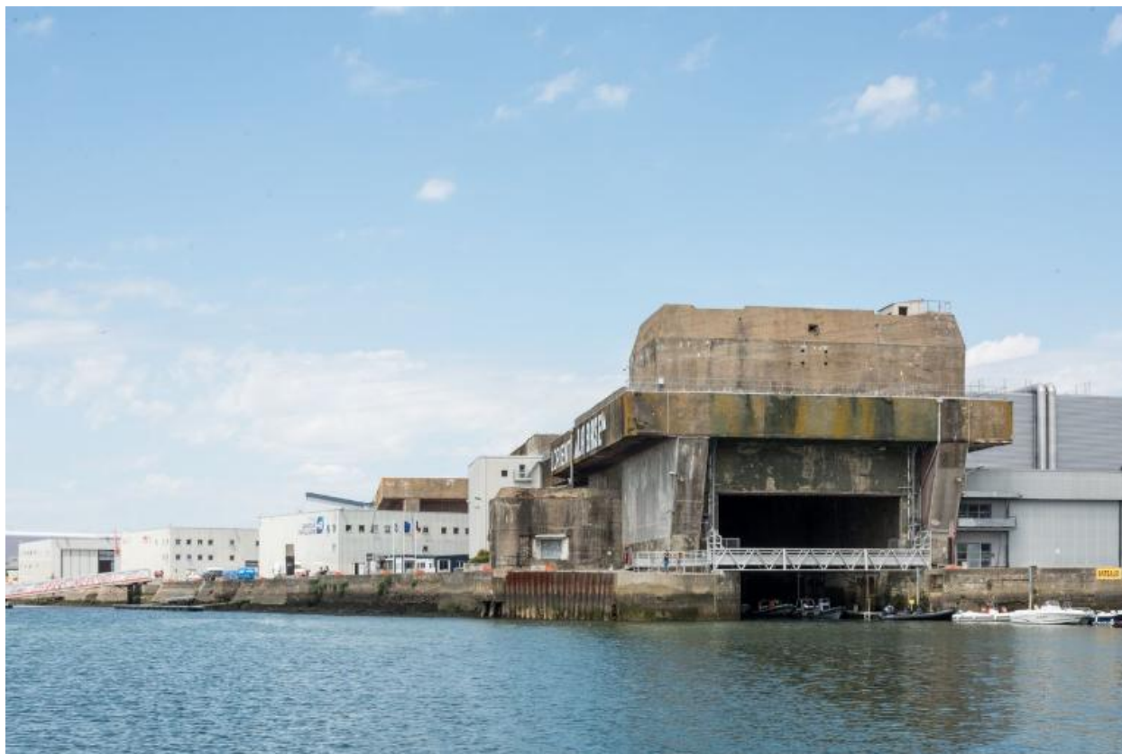
Vue de l'entrée du slipway et des docks
