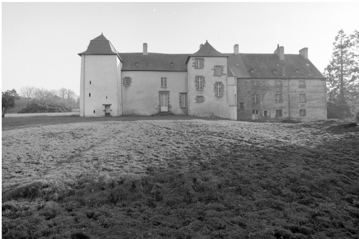
Façade nord, vue générale.
