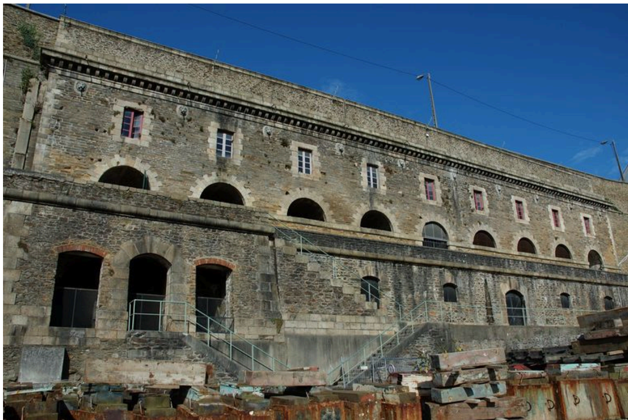
Vue générale de l'élévation orientale (contre-plongée)
