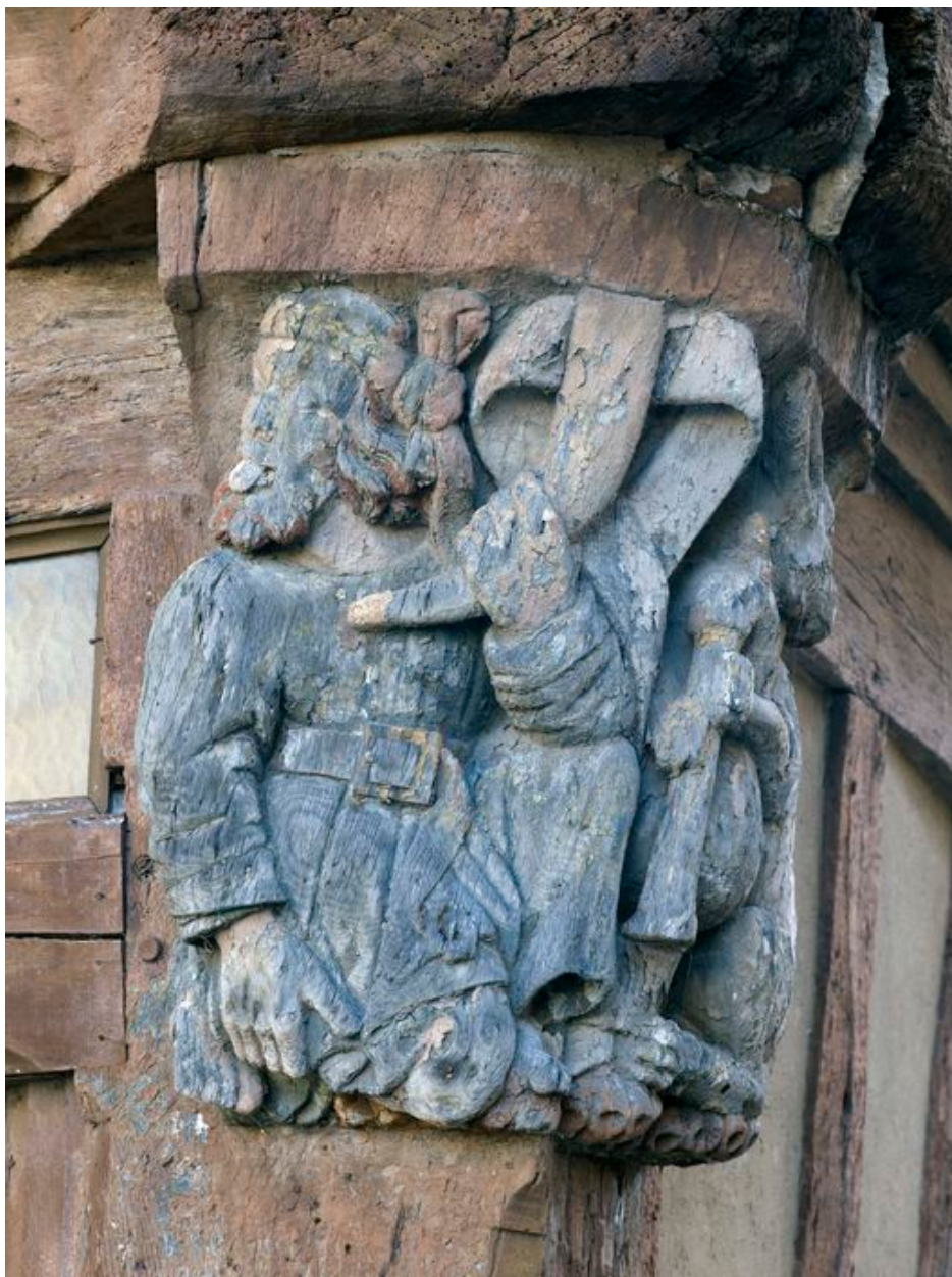
Angle sud-ouest, rez-de-chaussée, décor de l'aisielier du poteau cornier : homme jouant du cor (état en 2012)
