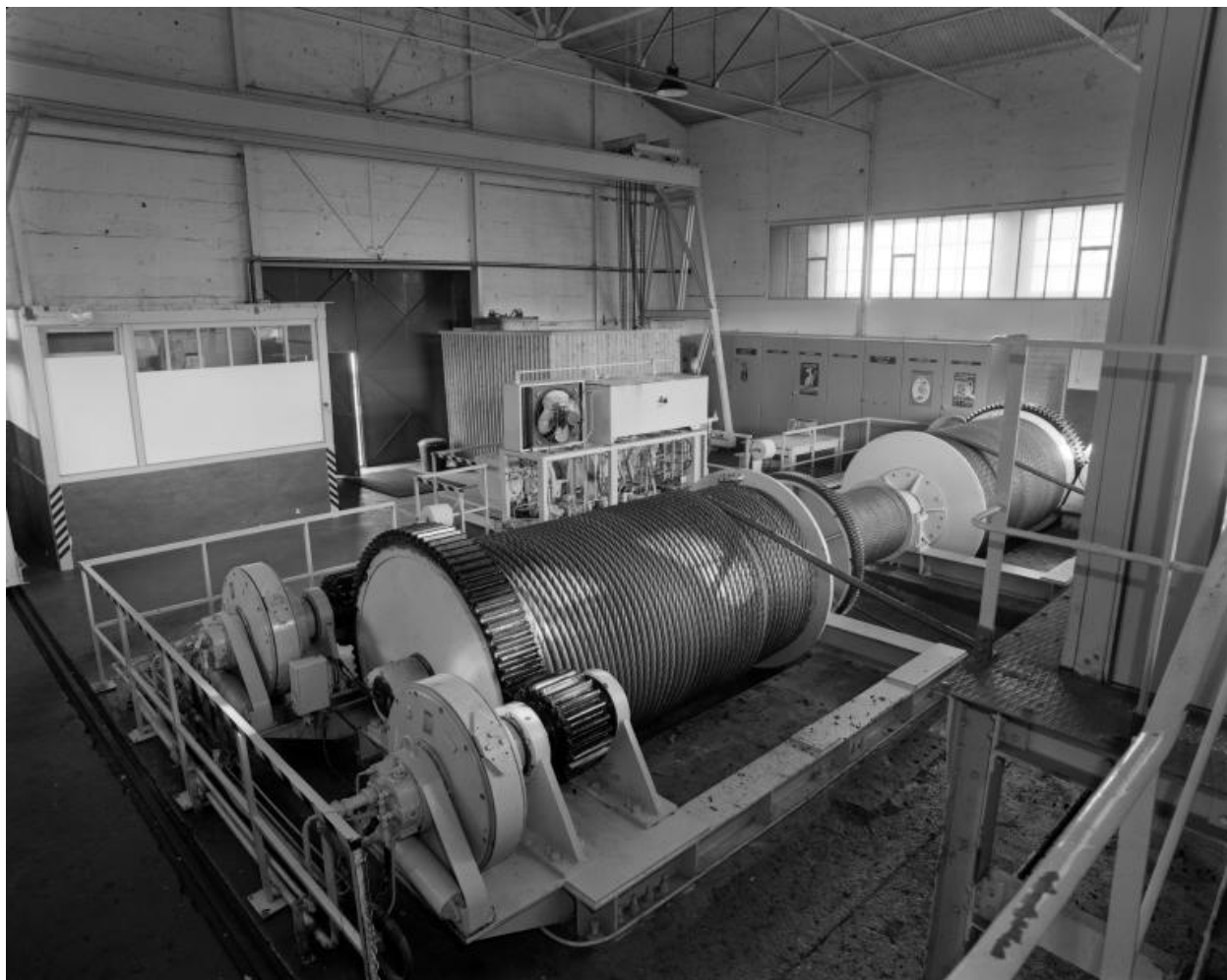
Vue du treuil de hissage principal du slipway en 2000
