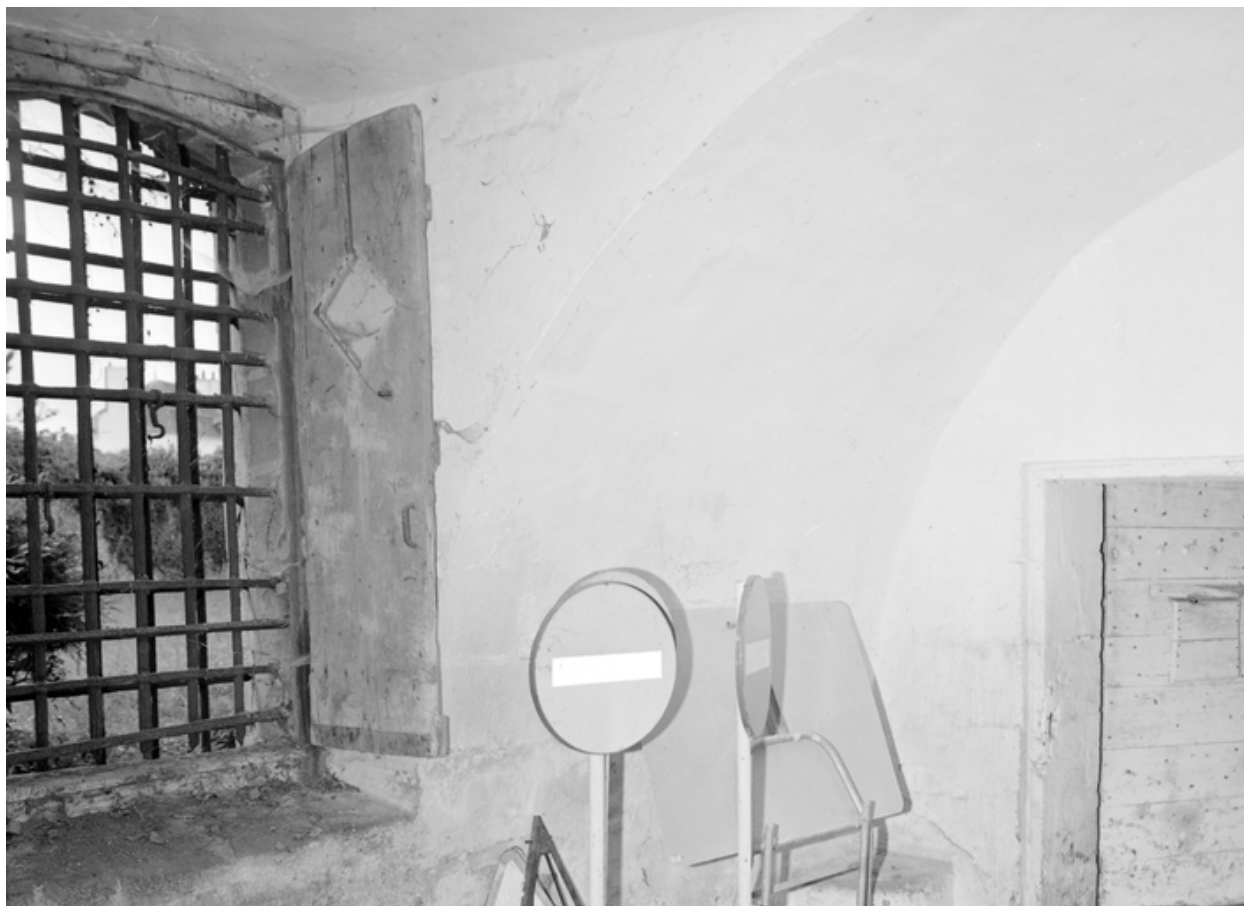
Cachot du rez-de-chaussée sud, vue générale.
