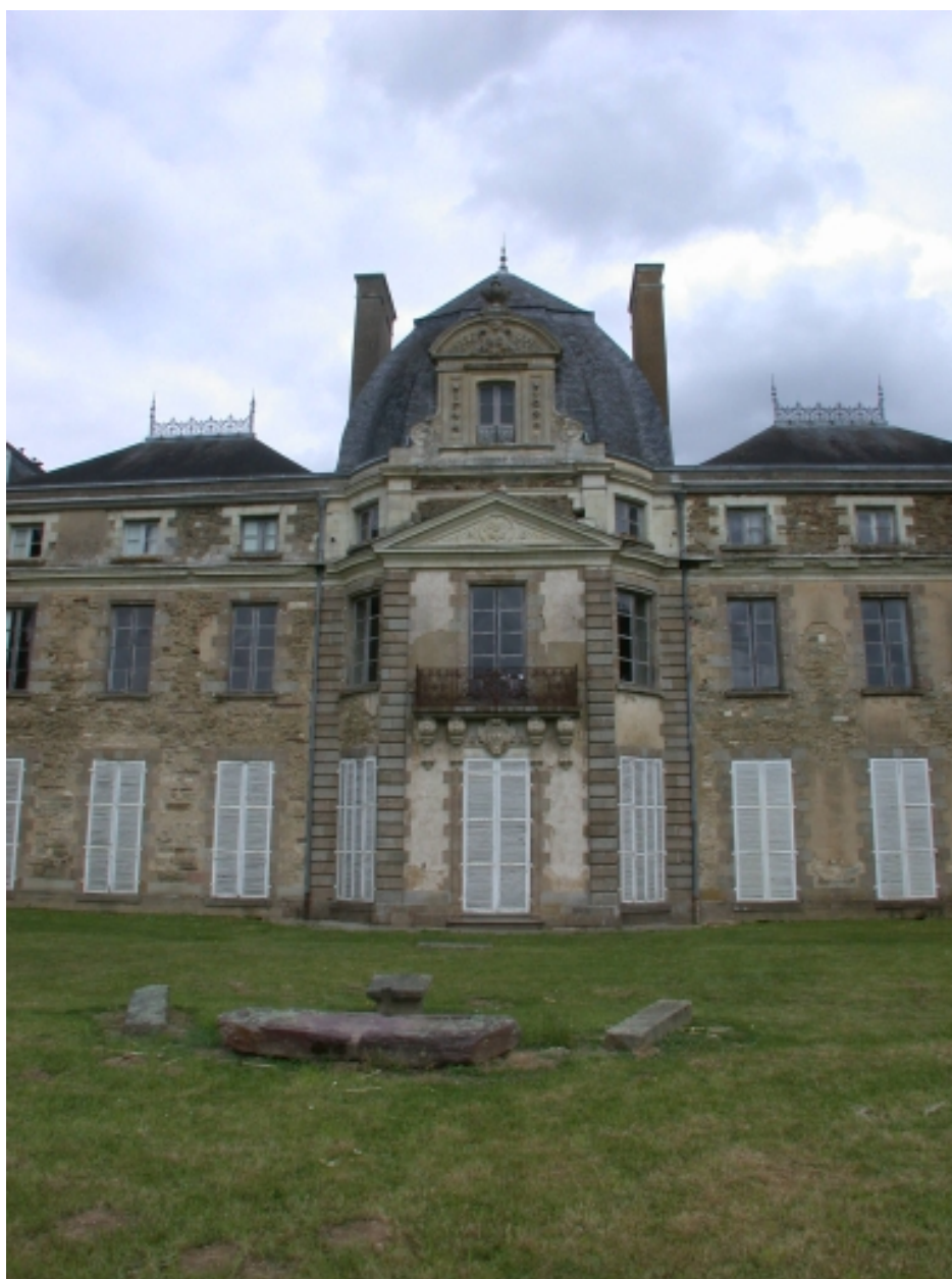
Château, façade sur jardin : détail de la travée centrale
