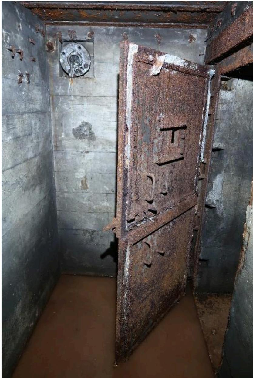
Vue de la petite salle située au nord-est : une porte blindée à deux vantaux isole des salles de garde. Derrière la porte se trouve une bouche de soufflage (non visible) et une bouche de surpression à clapet à contrepoids en aluminium
