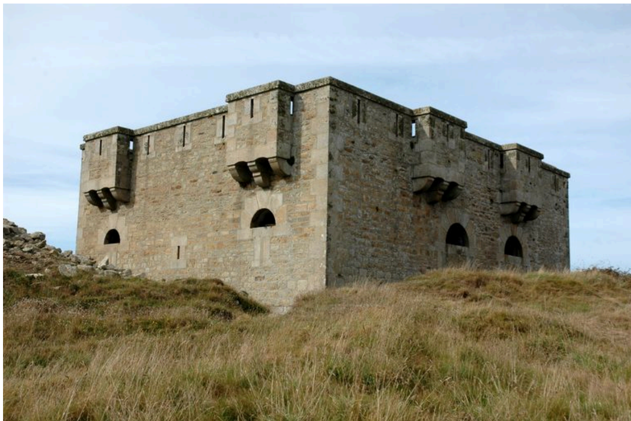
Vue du réduit de batterie de côte de Loqueltas, angle sud-est
