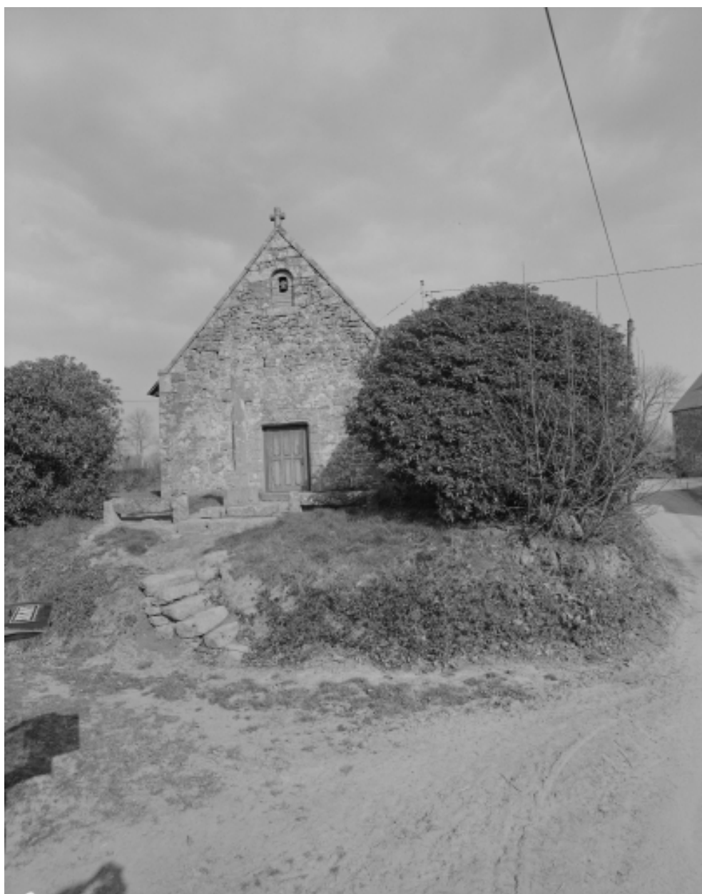
Elévation Ouest : vue de situation
