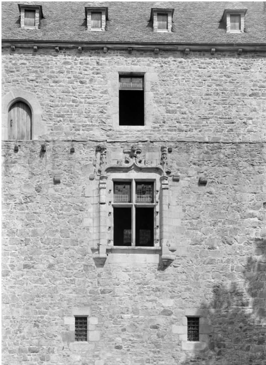
Vue depuis le sud-ouest : détail de l'élévation antérieure, dernière travée, au centre, fenêtre de la chambre seigneuriale à l'extrémité sud (état en 1974). Elle arbore un décor gothique flamboyant
