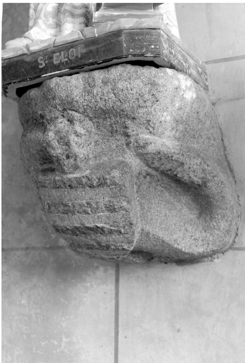
Croisillon sud, mur est : détail de la console historiée à gauche de l'autel
