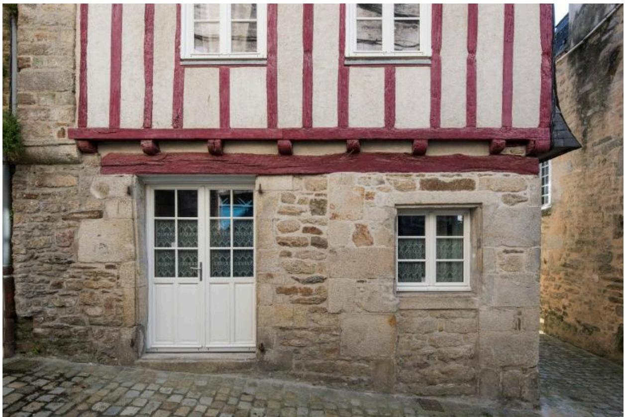
Des reprises au niveau des ouvertures se lisent dans ce rez-de-chaussée maçonné.
