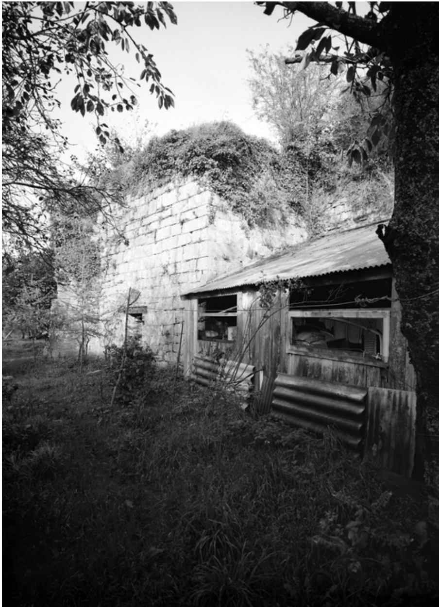
Vue sud-est de la tour
