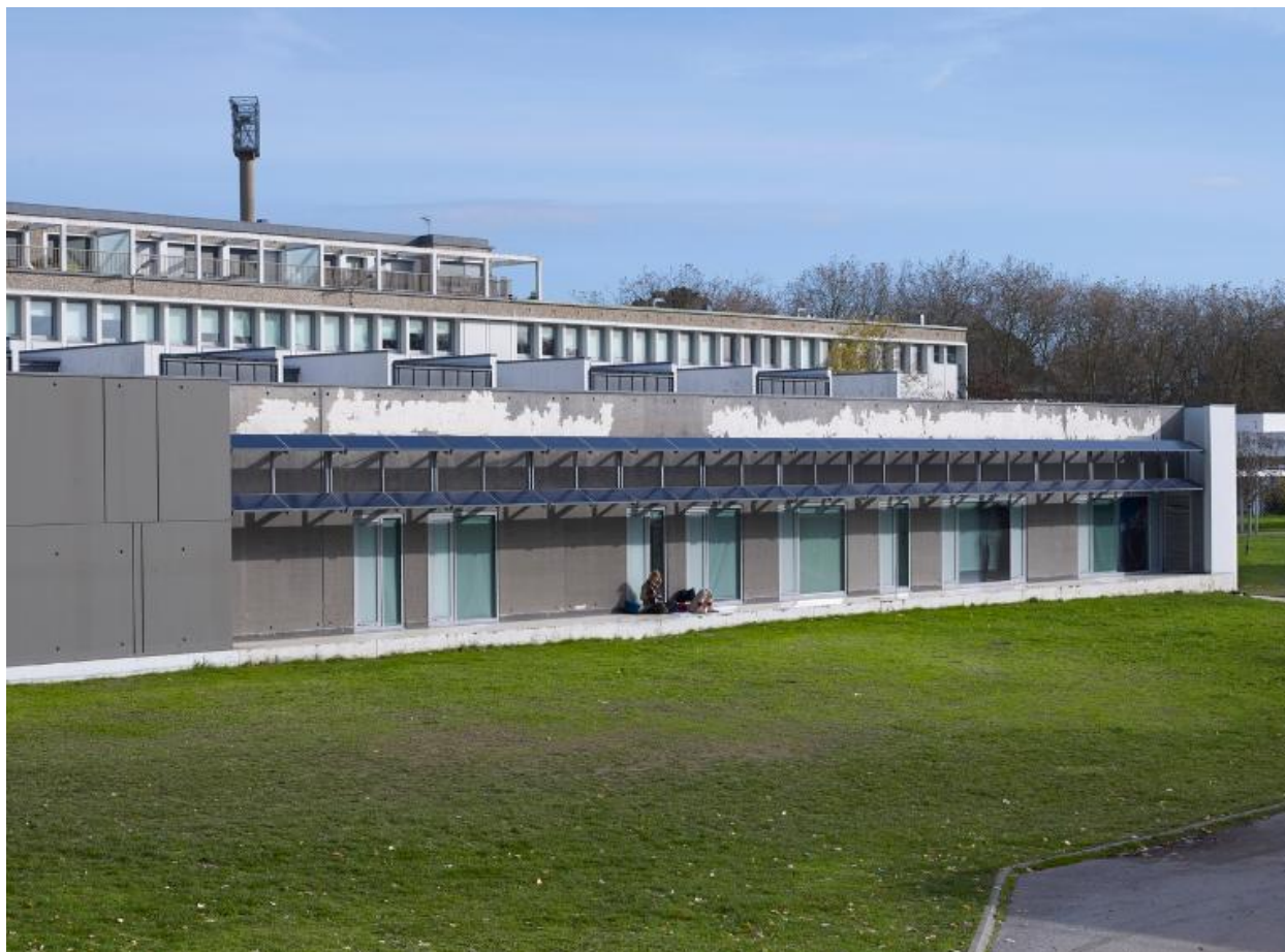
Façade arrière du CDI (S. Bertic et P. Debard, architectes, ca. 2005).
