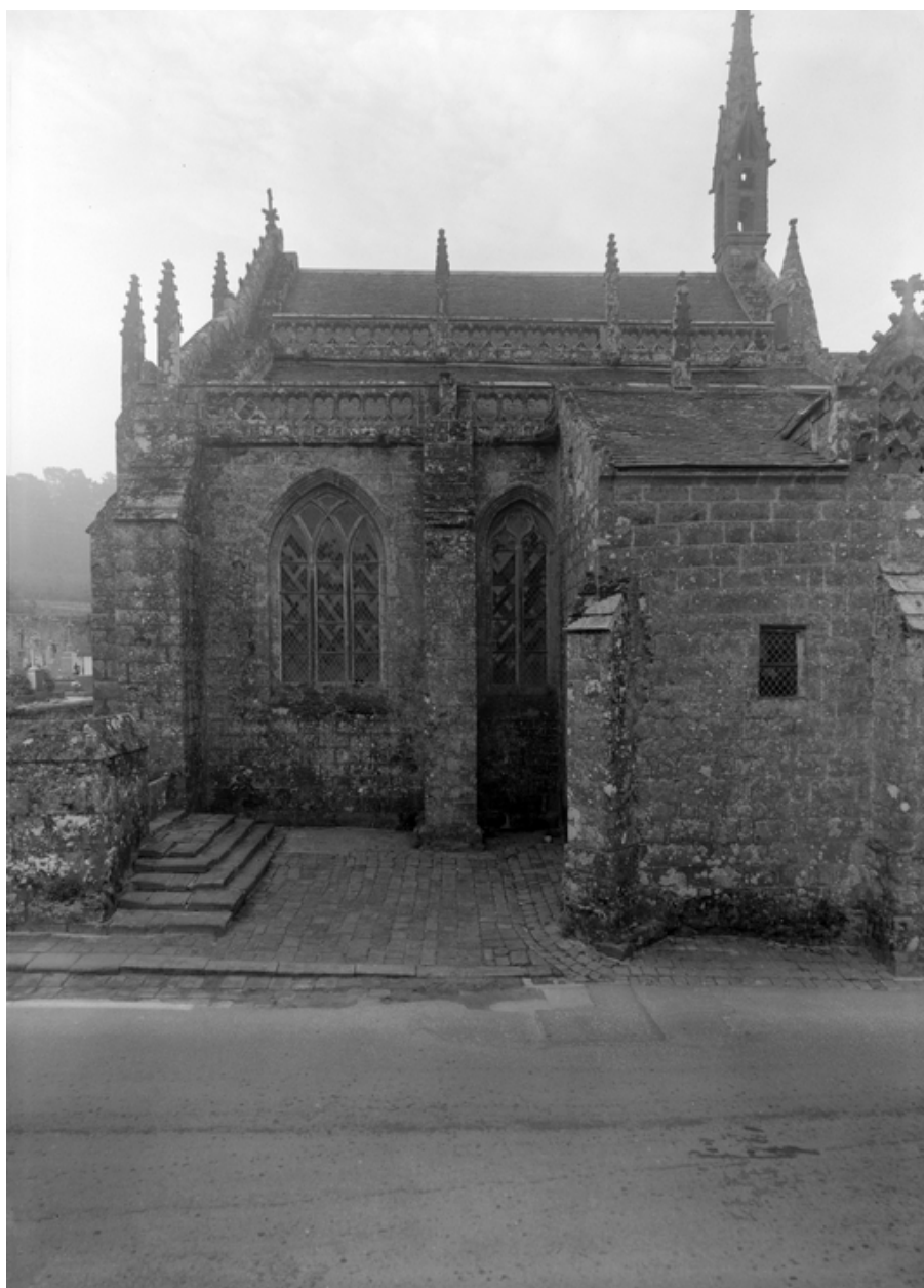
Façade nord, travées 6 et 7
