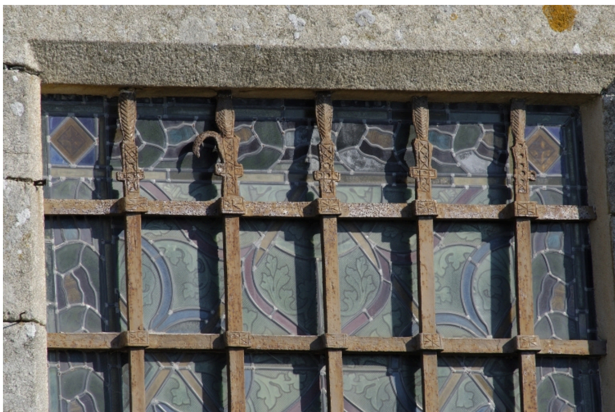
Détail de la grille forgée fenêtre sud
