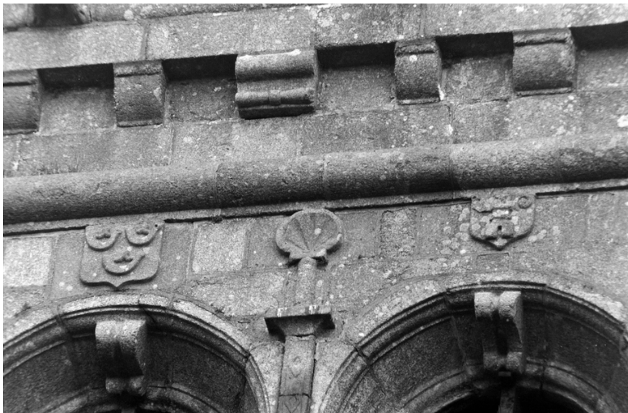
Tour, face sud, écu sous la corniche du 3ème niveau
