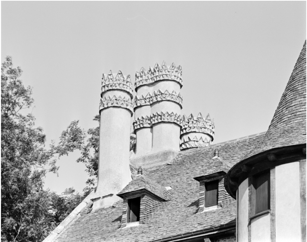
Vue des souches de cheminée du pignon nord (état en 1989). Elles sont enduites et ornées de motifs géométriques en schiste
