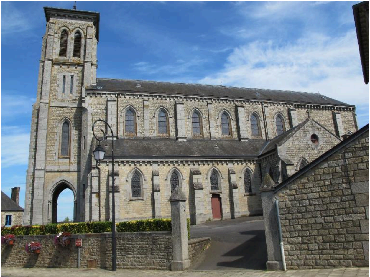
Vue générale du bas côté
