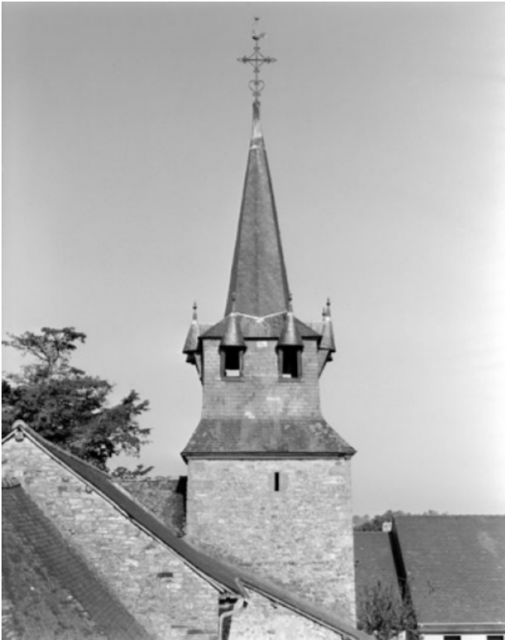
Elévation est, clocher : vue générale
