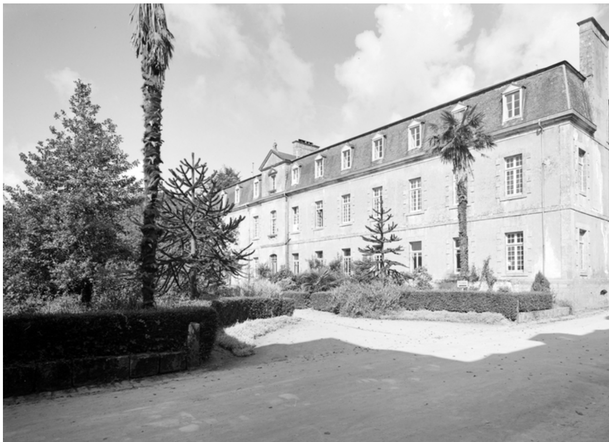
Corps de bâtiment G, bâtiments du musée, façade sud, extrémité est (1965)
