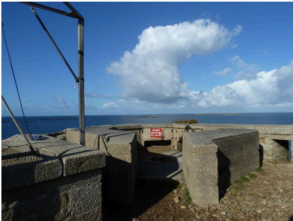
Saint-Pierre-Quiberon, fort de Penthievre, cuve à canon allemande.
