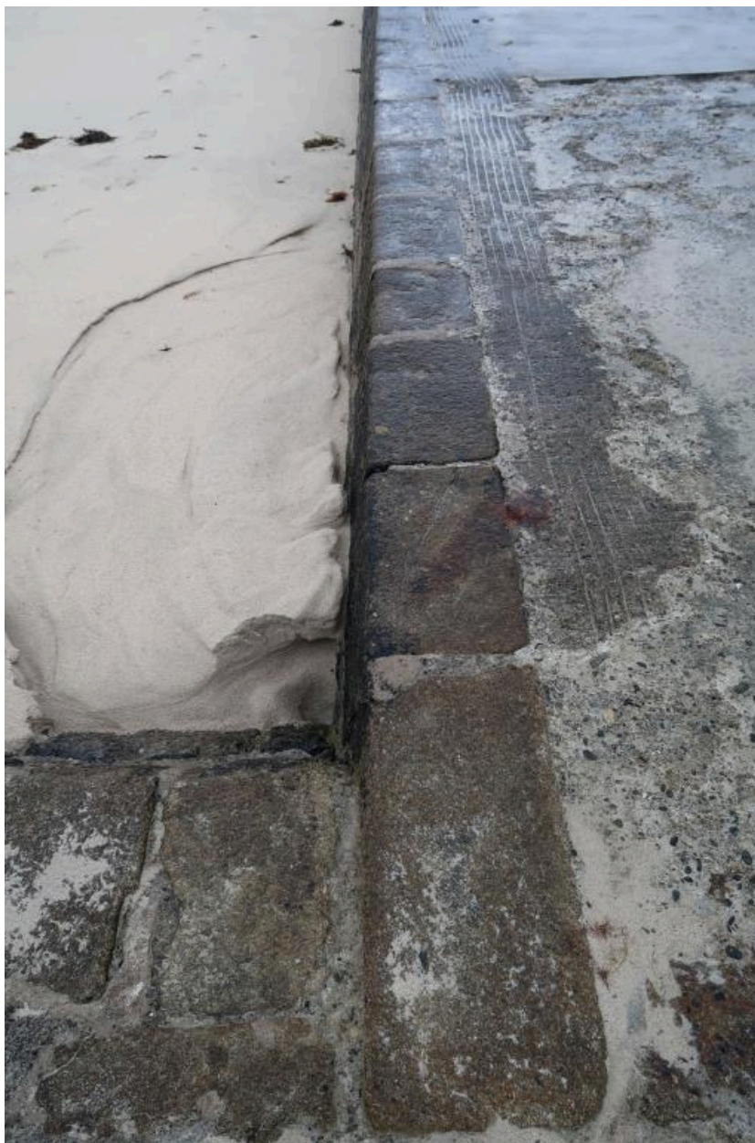
Ancienne digue de Sainte-Evette, platelage, pierres de taille
