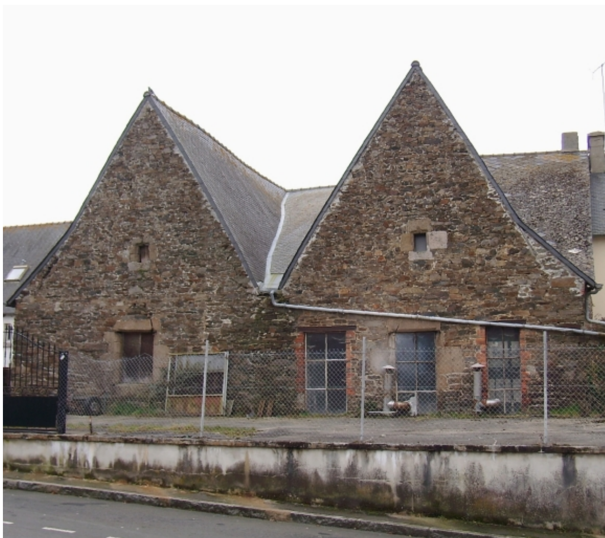
Vue générale (façade postérieure)
