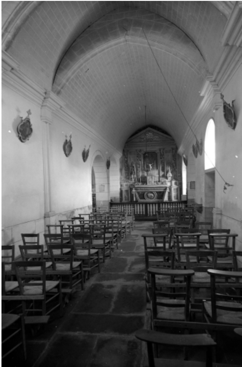
Nef vue d'ouest en est.
