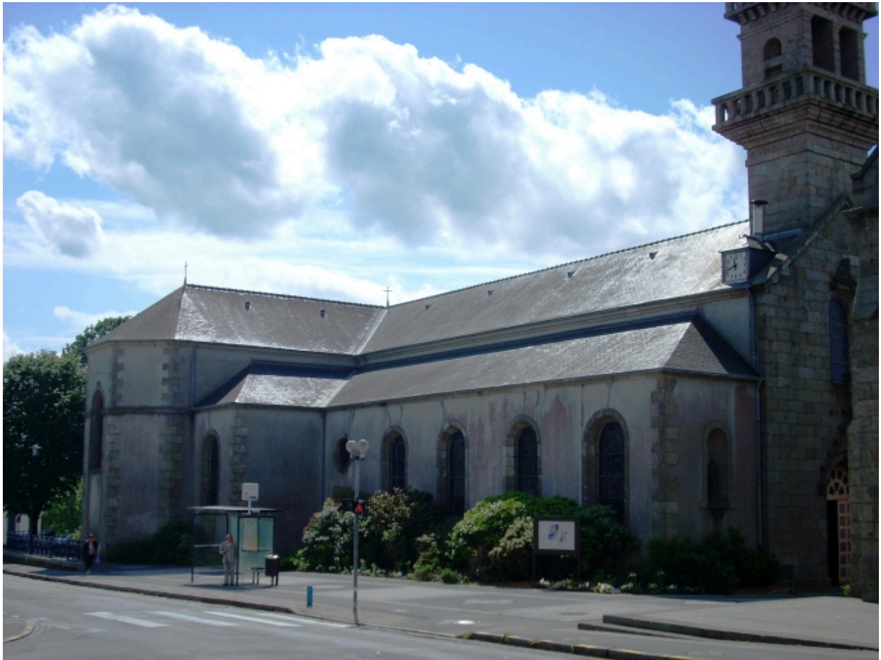
Brest, église Saint-Joseph : vue générale nord-ouest
